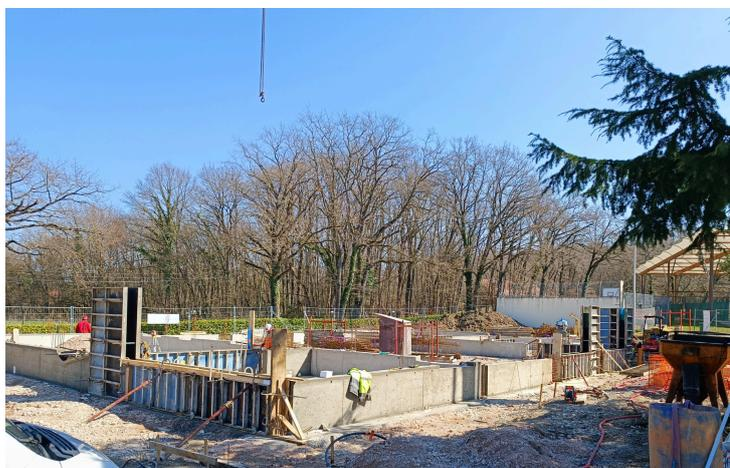
Des fondations profondes et "hors gel" sont réalisées par l'entreprise de maçonnerie. Dans ces tranchées, une semelle en béton armé en acier est coulée : elle permet de répartir la charge du bâtiment sur la surface de sol.
